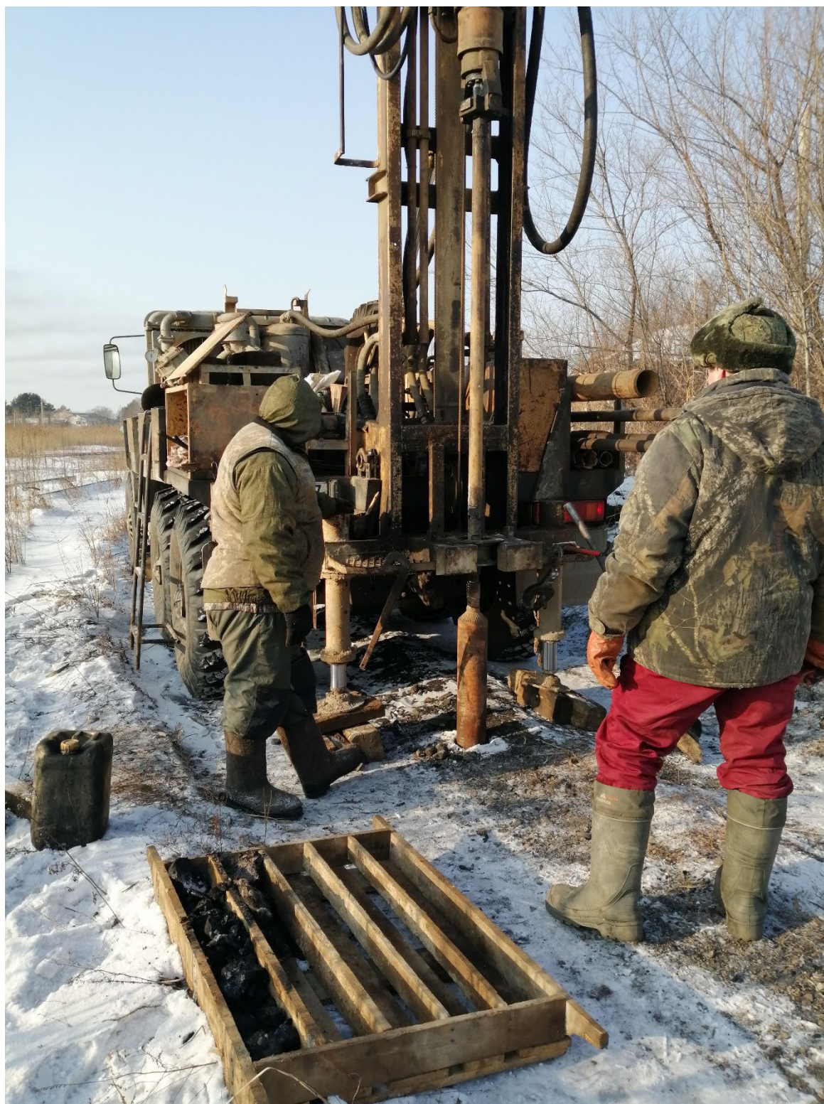
Рисунок 2 - Бурение скважины
